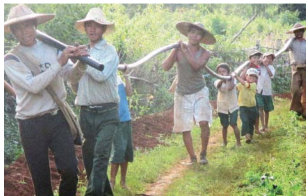
協力しあって水供給施設を建設する村人
